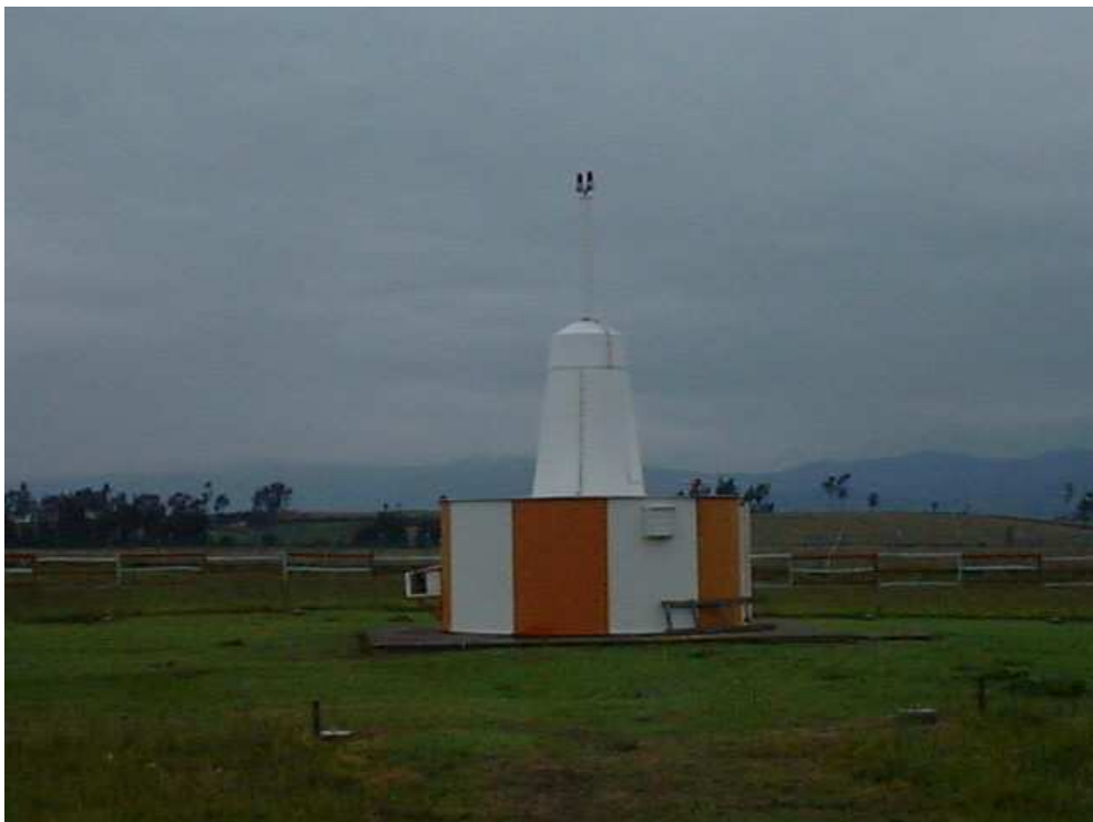
Fig. 7 Vista externa del VOR
